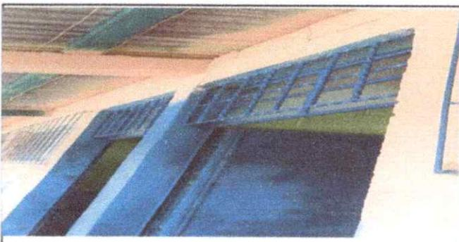
Foto 5: sustitución de vidrios y reparacion de barandal terminado
